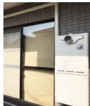
ベランダへの給湯器設置例
