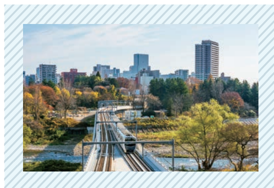
仙台市地下鉄東西線高架橋から臨む仙台市
